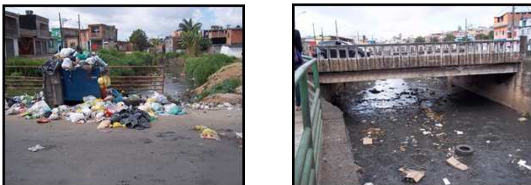
Figura 6: Presença de resíduos sendo descartados diretamente no Córrego Itaim ou acumulados de maneira errada ao lado do mesmo.
