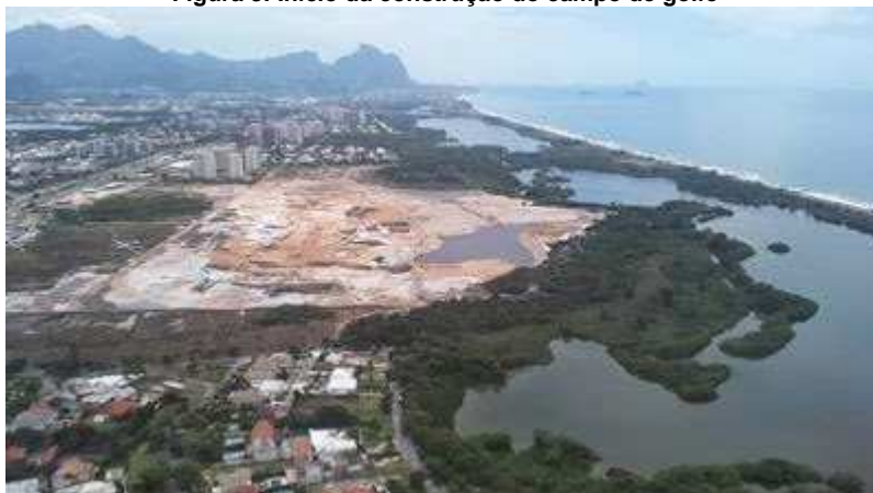
Figura 3: Início da construção do campo de golfe
